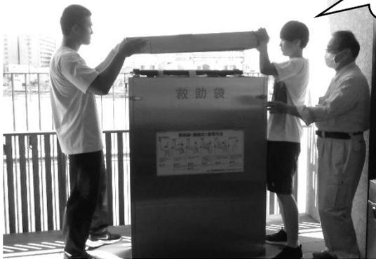
救助袋が収納されている箱の蓋を開け、側面カバーも外します。
